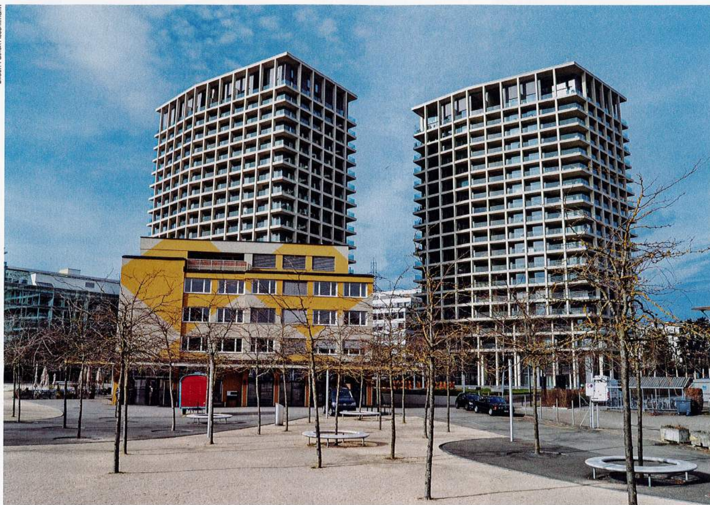
Gehobenes Wohnen am Stadtrand: Die beiden Wohntürme «The Metropolitans» mit dem Leutschenpark.
